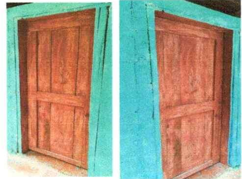
Foto 4: Puertas necesarias, para mayor seguridad
