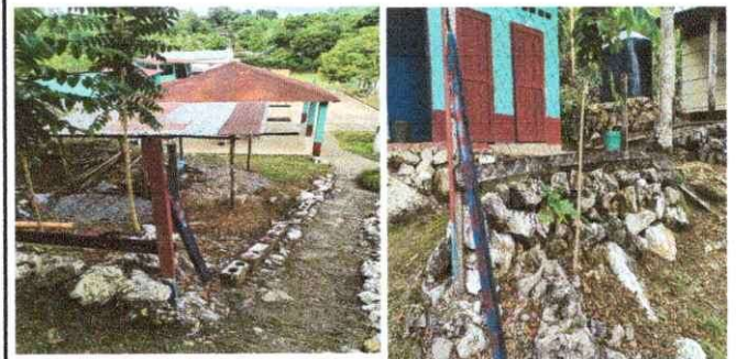
Foto 6: Necesidad de reparación de acceso a los baños y muro de contención.
