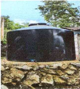
Foto 1: REPARACION Y MANTENIMIENTO DE DEPOSITO DE AGUA
