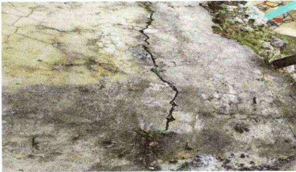
Foto 3: Reparación de piso del salón de clases
