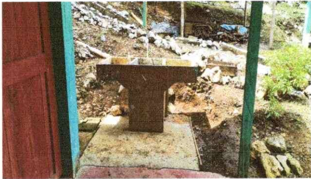
Foto 3: Condiciones actuales de la pila donde se deposita agua entubada.
