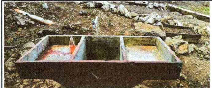
Foto 2: Mejoramiento de red de agua entubada
