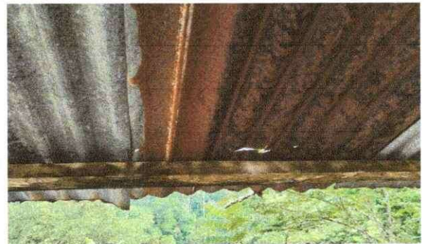
Foto 6: Estructura y techo actual
